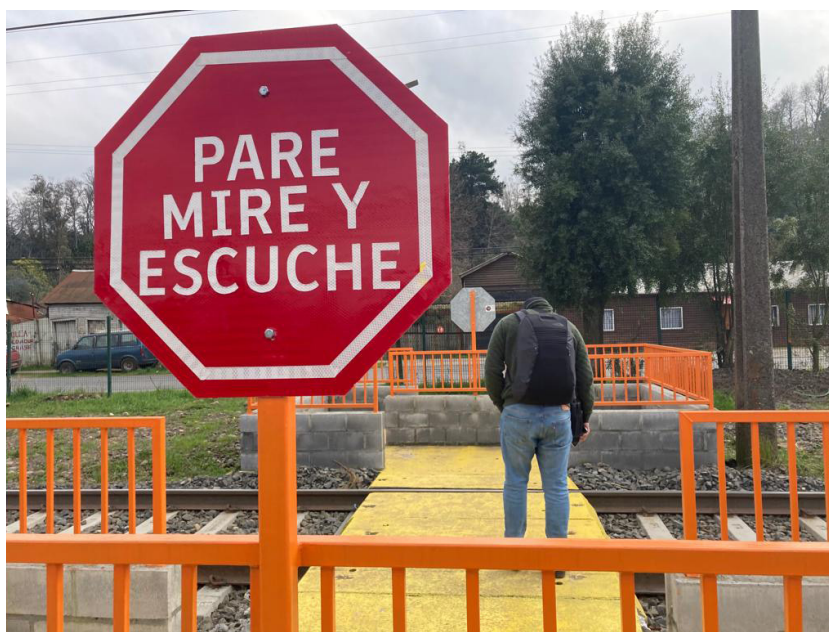
Cruce de Ferrocarril en Cajón.
